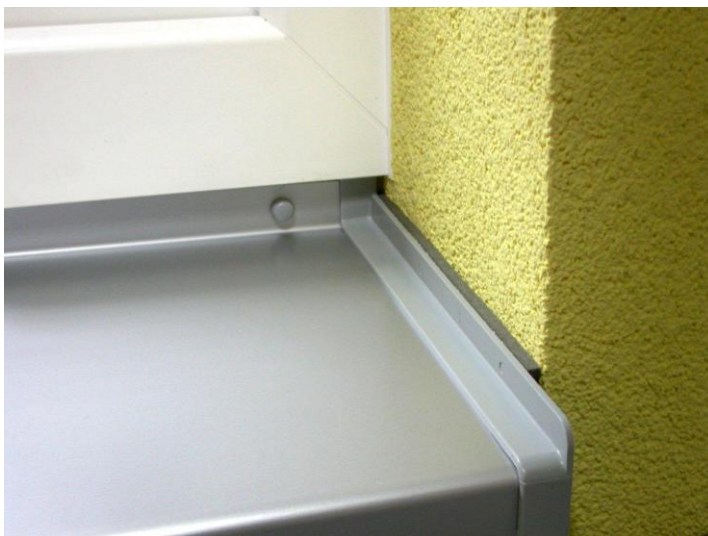
Abbildung 9: seitlicher Abschluss mit vorkomprimiertem Dichtband
