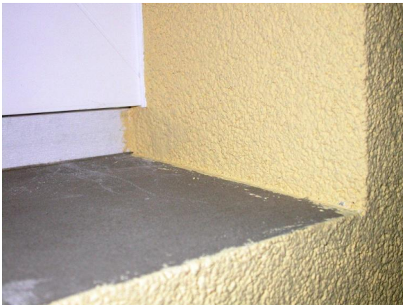
Abbildung 10: Zweite Dichtebene mittels fertig beschichtetem Parapet (Dichtschlemme)
